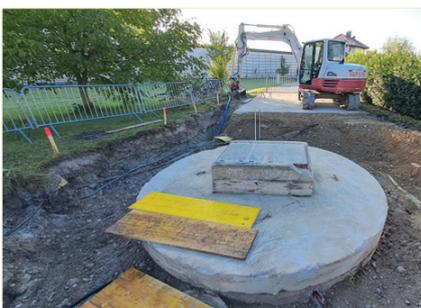
September mit dem Neubau des Pumpwerkes begonnen. Da das bestehende Bauwerk einen Durchmesser von 4 Meter und eine Tiefe
