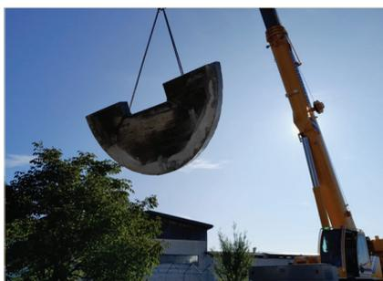
von circa 8 Meter hat, wurde die Abdeckung des Bauwerkes entfernt und das neue Pumpwerk hineingesetzt. Die Arbeiten bis zur Inbetriebnahme der neuen Technik haben in etwa 3 Wochen in Anspruch genommen. Die Abwasserentsorgung war während der Bauarbeiten jederzeit gewährleistet.
